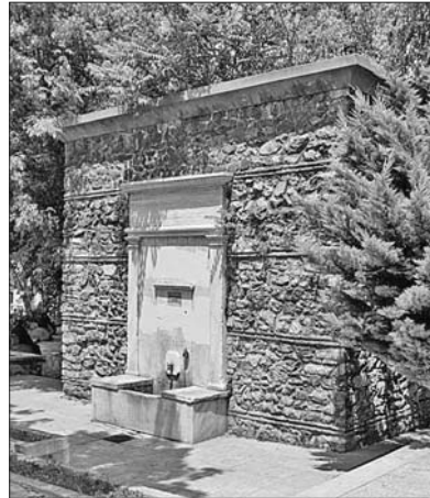
Sultan II. Mahmud Çeşmesi ile Şeyh Devâtî Camii avlu duvarına bitişik kitâbesiz çeşme
